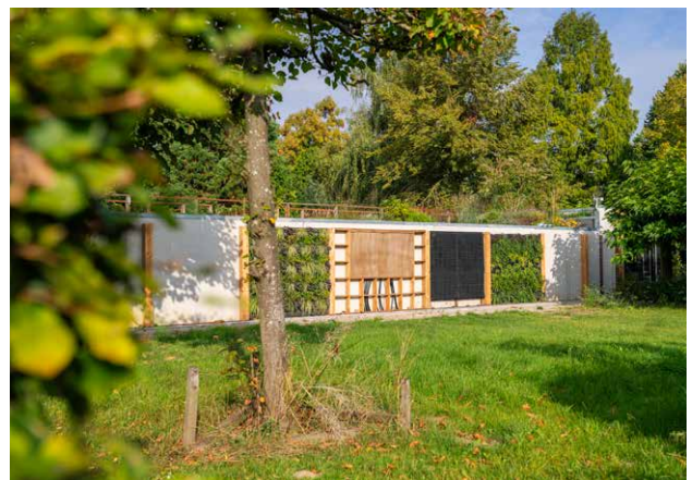
^ Acht verschillende systemen met gevelgroen onttrekken de betonnen buitenwanden aan het zicht. (Foto: Bart van Rongen)
